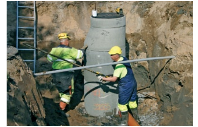
Jussi Pönkkö ja Jari Rukolainen rakentamassa vesihuoltoa Mustasuon työmaalla.
